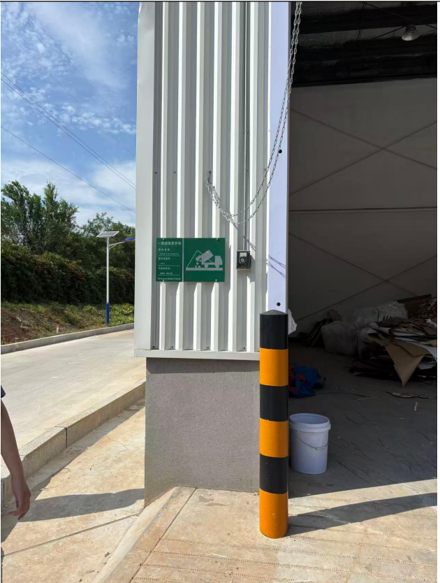
一般工业固废暂存间
