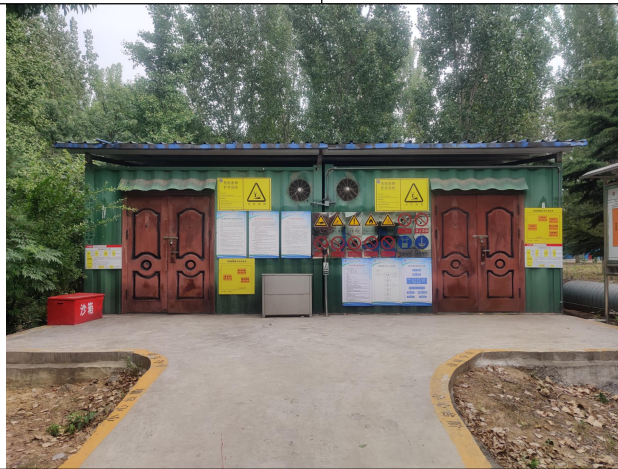
危险废物暂存间
