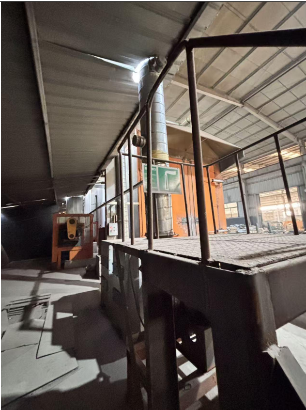
两级活性炭吸附装置+采样平台+采样口 (DA008)
